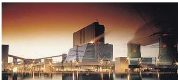
Chauffage et électricité
