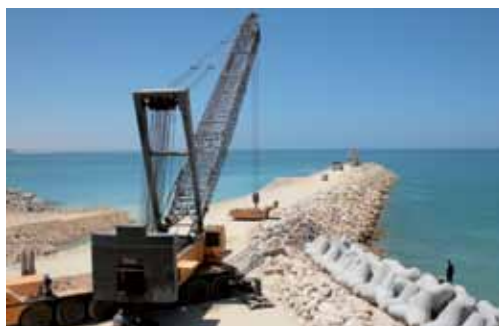
▲ Chantier de Boujdour.
