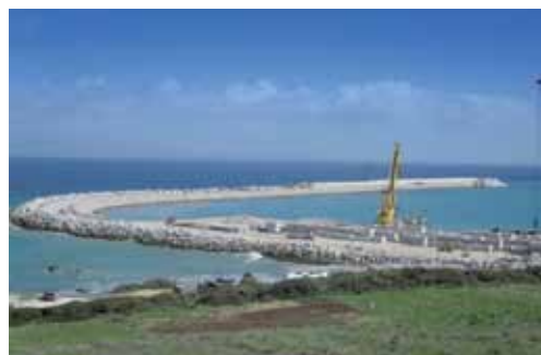
▲ Chantiers du port de Ksar Sghir.
