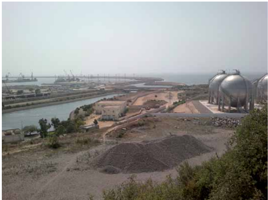
▲ Port de Jorf Lasfar et zone industrielle.
