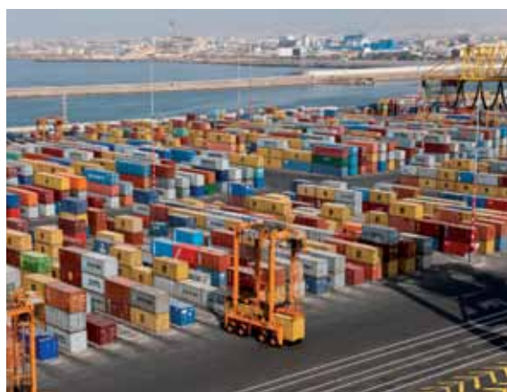
▲ Port de Casablanca. Terminal à conteneur Est.
