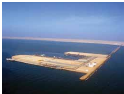
▲ Port de Dakhla avant l'extension.
