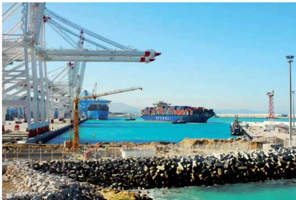
▲ Port de Tanger Med. Terminal à conteneur.
