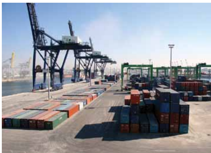
▲ Port de Casablanca. Terminal à conteneur 2
